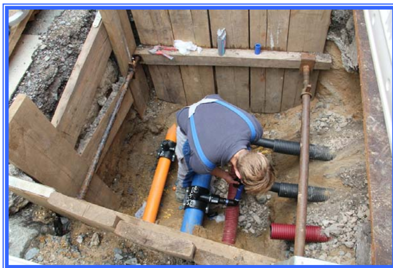
Erneuerung von Leitungen
