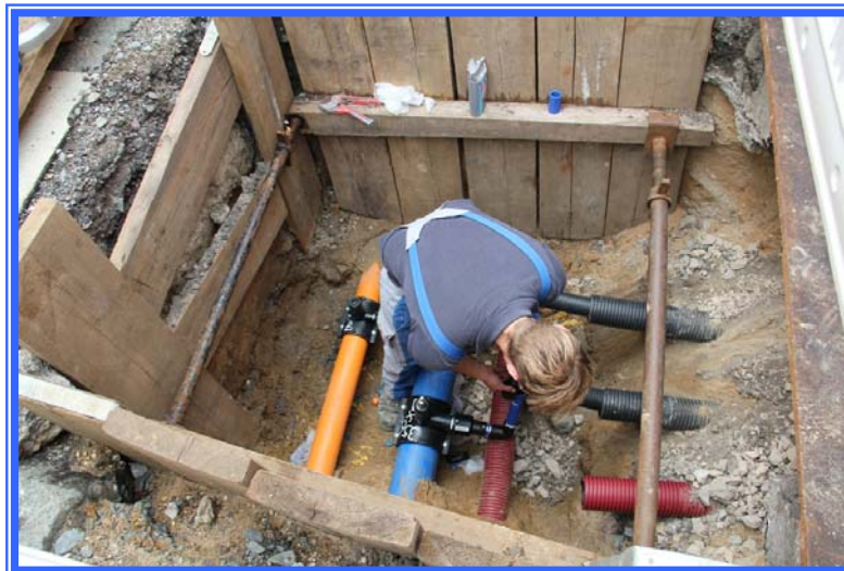
Erneuerung von Leitungen
