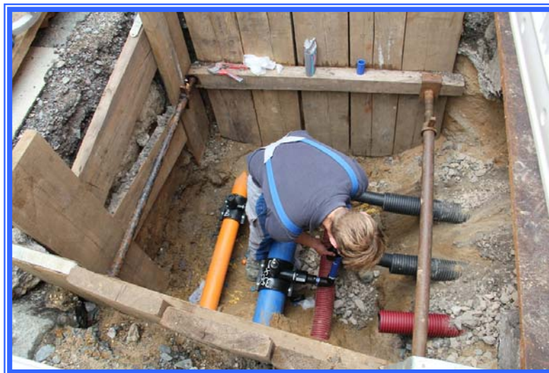
Erneuerung von Leitungen
